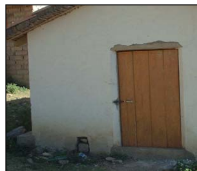
Ventanas de ventilación, cerca del suelo, dejan que las papas respiren
