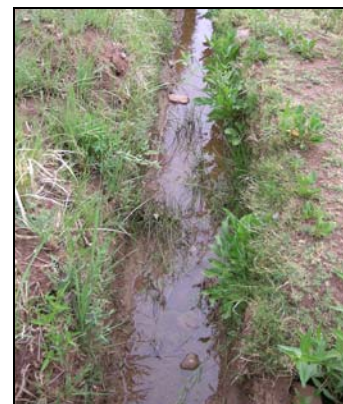
Las hierbas tapan los canales. Es bueno limpiarlos.
